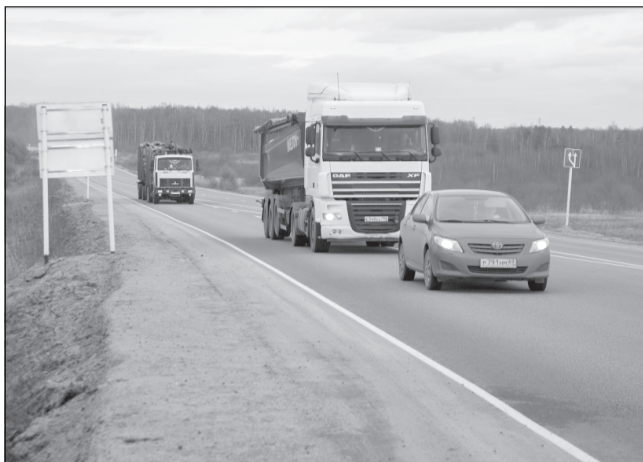
Автомобильная дорога после ремонта. Фото: Дмитрий Рыжак
